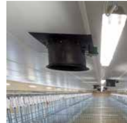
ВЕНТИЛЯТОР В РАМЕ С ЗАЩИТНОЙ СЕТКОЙ
